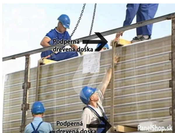
(Vista della piastra di supporto in legno dal basso e dall'alto sulla confezione)
